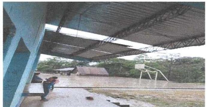
Foto 4. Sustitución de láminas y base de estructura no adecuado del corredor del establecimiento.
