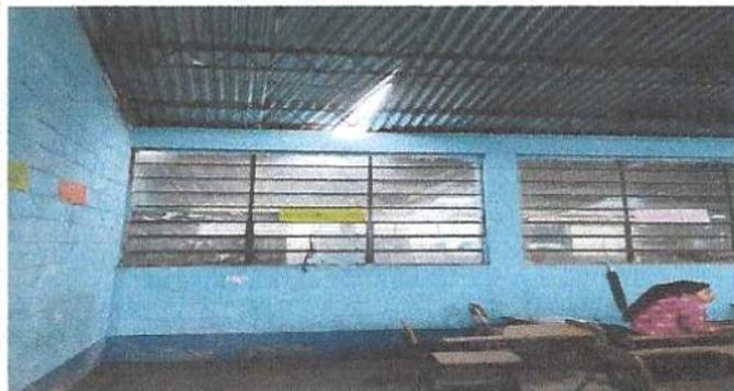
Foto: 3 Sustitución de lámina y base de estructura no adecuado.
