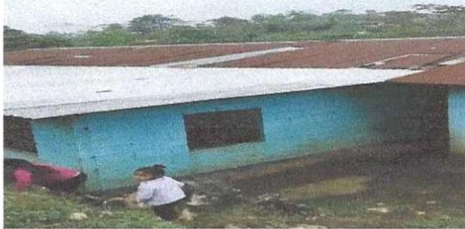
Foto 5: parte posterior de la escuela en donde se ve el techo levantado
